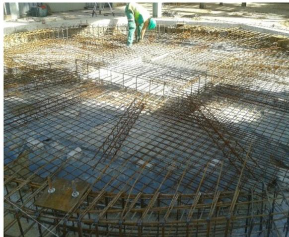
Ferrailage avant coulage dalle béton
