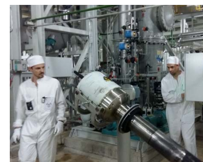
Torche à plasma - installation KNPP
