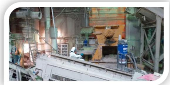
Démontage convoyeur, zone préparation de charges
