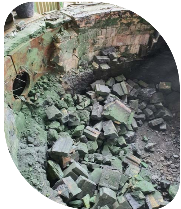
Réfractaires | Déconstruction du four Inertam
