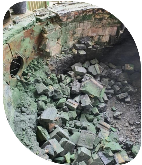
Réfractaires | Déconstruction du four Inertam
