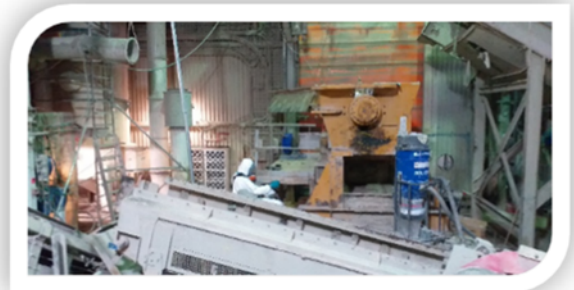
Démontage convoyeur, zone préparation de charges
